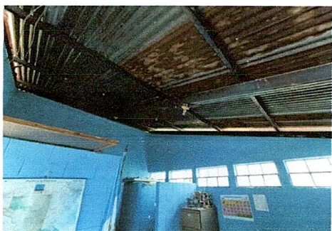
Foto 3: Acá nos muestra la falta de servicios de cableado y la falta de accesorios eléctricos para la iluminación de los servicios sanitarios.
